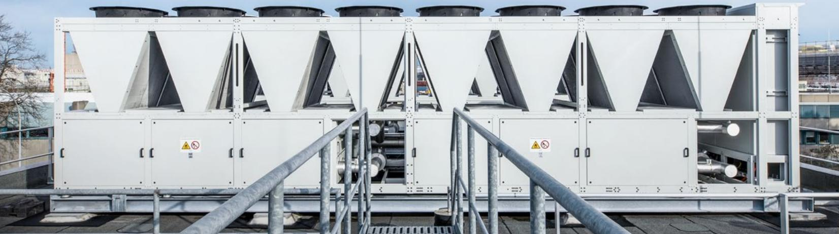
**Natürliche Kältemittel sind auf dem Vormarsch. Während bei Kälteanlagen im Megawatt-Bereich bisher vor allem Ammoniak eingesetzt wurde, stösst nun auch Propan ins obere Leistungsegment vor. Dies unterstreicht die Erweiterung der Energiezentrale auf dem Stücki-Areal in Basel durch zwei Propan-Kälteanlagen der CTA mit je 1,2 MW Kälteleistung.**
