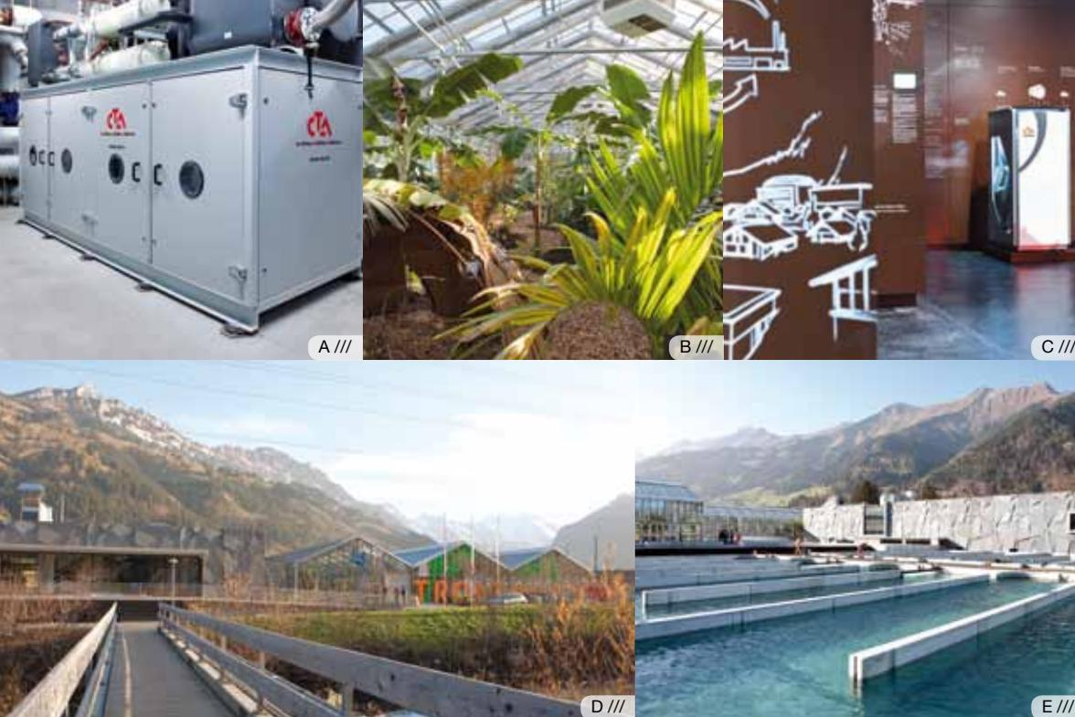
A /// Die schalldämmte Bauweise der CTA**exklusiv**-Wärmepumpen ermöglicht eine Schallreduktion von ca. 20 dB.
