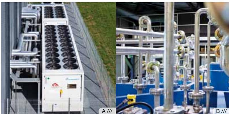
A /// Die CTA-Anlage besteht aus einem luftgekühlten Kaltwassersatz mit 100% Wärmerückgewinnung, einem luftgekühlten Kaltwassersatz mit Enthitzer sowie einem Rückkühler.
