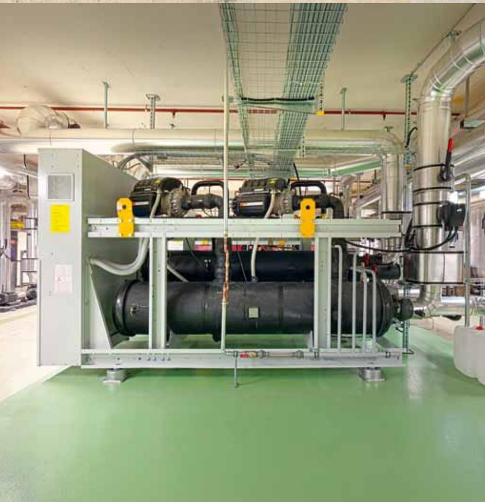
B /// Im Rahmen des ECO-21-Programms beschloss das Unternehmen DuPont de Nemours seine alten Kältemaschinen durch CTA-Kältemaschinen mit Turbocor-Kompressoren zu ersetzen und so jährlich rund 1.5 GWh einzusparen.
