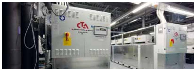
**Zwei CTA-Kältemaschinen TECS HF4 arbeiten mit einer Kälteleistung von je 1207 kW. Diese Modelle umfassen magnetgelagerte Turbocor-Kompressoren.**
