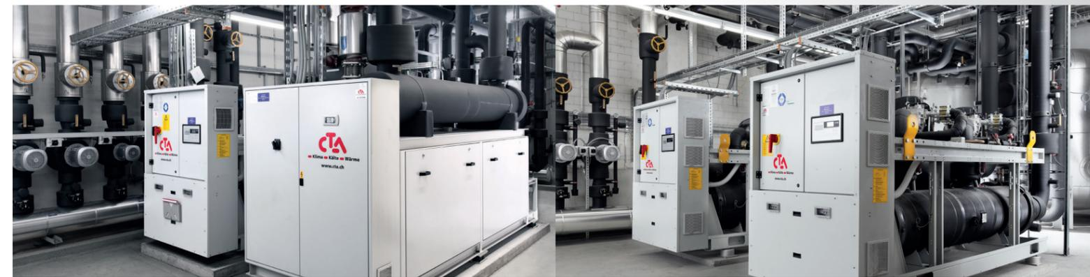
Beim Einkaufszentrum Metalli in Zug wurden die Anlagen zur Kälteerzeugung komplett erneuert und mit energieeffizienten Maschinen ersetzt.
