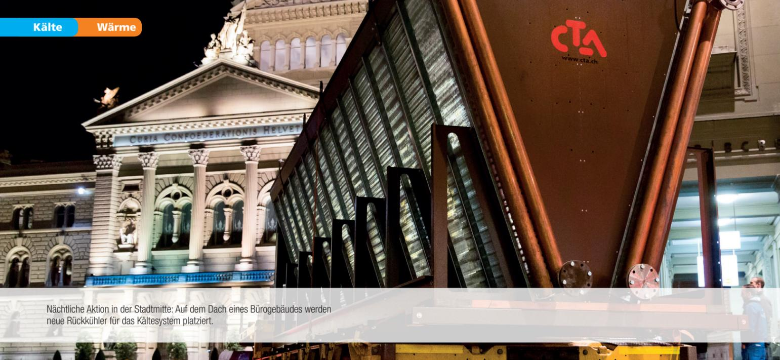
Nächtliche Aktion in der Stadtmitte: Auf dem Dach eines Bürogebäudes werden neue Rückkühler für das Kältesystem platziert.
