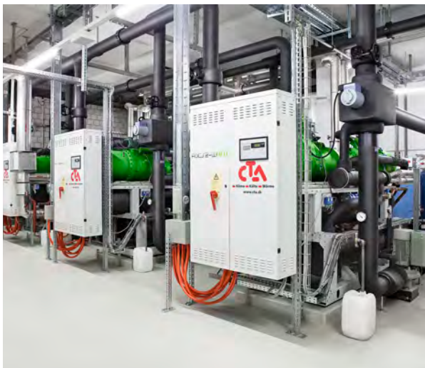
HFO-Kältemaschinen mit Schraubenverdichter
