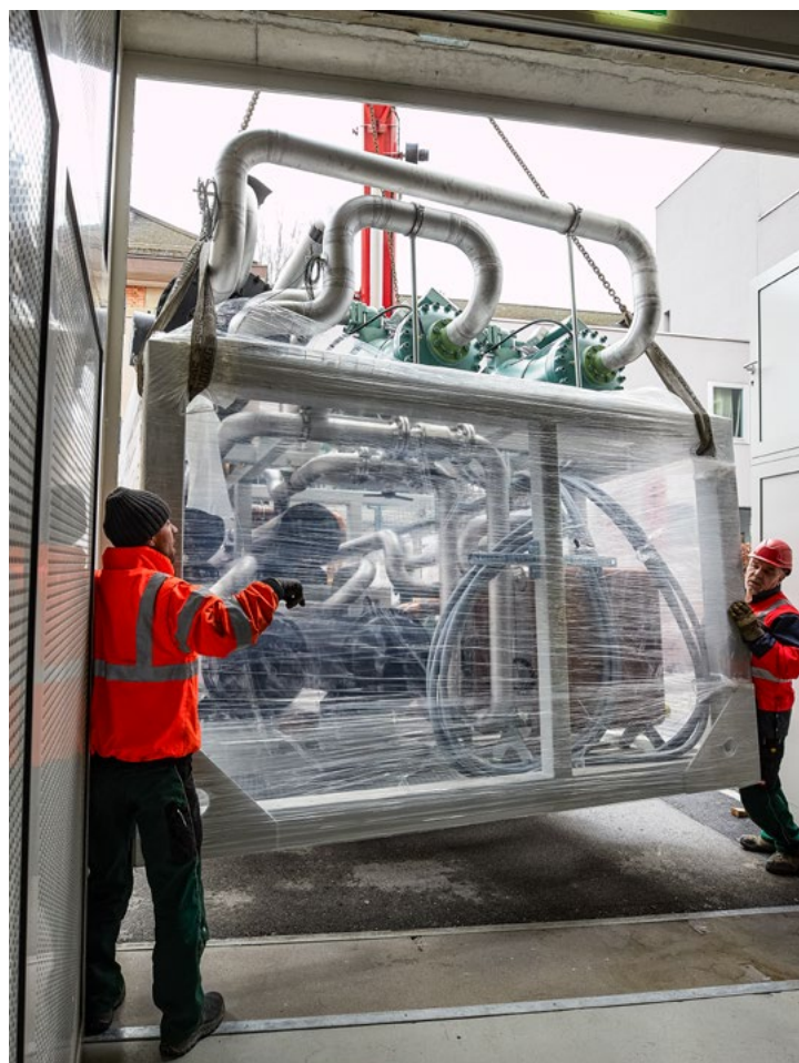
Einbringung der 1,6 MW HFO-Kälteanlage ins Inselspital
