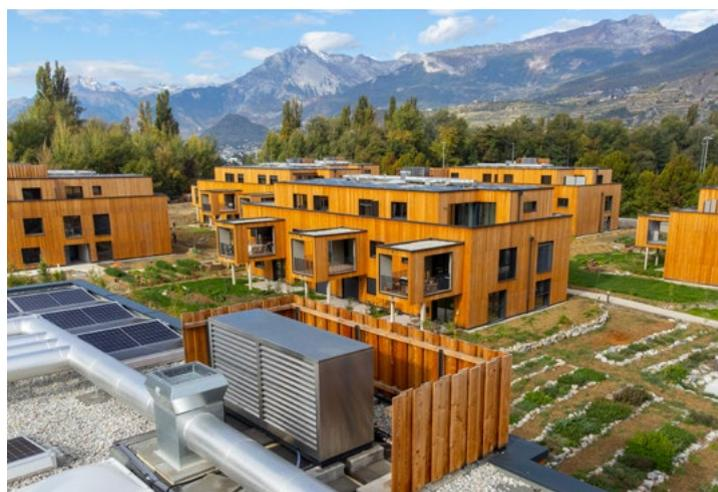
Mit 49 dB(A) Schallleistung ist die Ausseneinheit in dieser Leistungsgröße über den gesamten Auslegungsbereich sehr leise.
