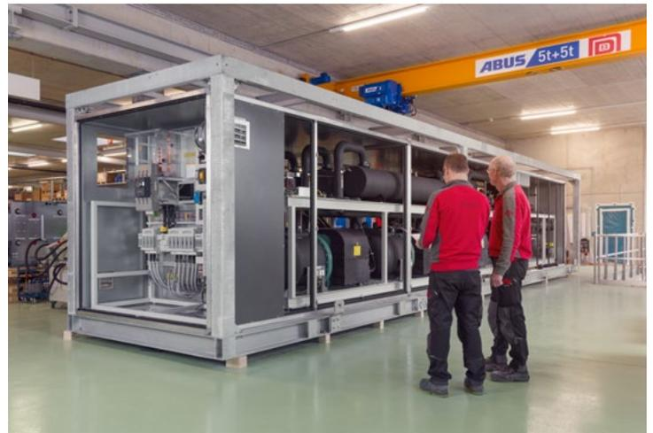
Die robuste HFO-Maschine der CTA versorgt das Kältenetz je nach Betriebsart (Klima- oder Prozesskälte) mit 16 °C oder 24 °C Kaltwasser. Der Kälteerzeuger verfügt über drei grosse Schraubenverdichter mit je 500 kW Kälteleistung. Jeder Verdichter kann mittels Frequenzumrichter stufenlos zwischen 50 und 100 Prozent geregelt werden, was wiederum eine ideale Abstimmung von Kältebedarf und Kälteerzeugung ermöglicht.
